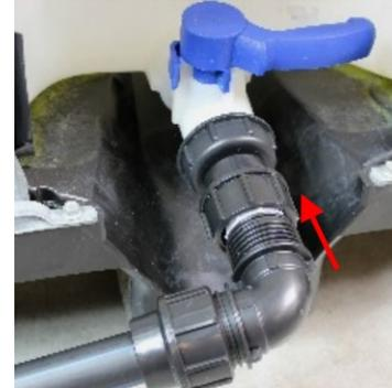
**4** Im Klemmfitting befinden sich noch das Einlegeteil sowie der O-Ring. Schieben Sie nun den Stutzen in den Klemmfitting. Der Grip-Ring wird damit nach hinten geschoben und erreicht seine passende Position.
