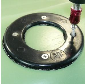
Legen Sie den Abdeckrahmen mit der "Dichtschnur" nach unten auf die Folie, so dass durch die Schraubenlöcher Ihre Stechmarkierungen mittig zu sehen ist. Verschrauben Sie den Abdeckrahmen mit der Folie und dem Flanschegestück auf der Rückseite der Folie.
