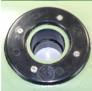
Anschließend entlang des Flanschunterteils die Folie sauber ausschneiden.
