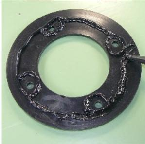
Drehen Sie den Abdeckrahmen um und ziehen Sie auf der Unterseite eine "Schnur" mit **SuperStrong** o.ä.
