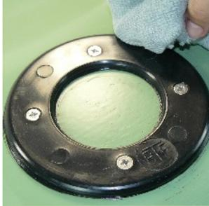
Wischen Sie die überschüssige, ausquellende Dichtmasse mit einem Lappen weg. Es sollte ganzflächig Dichtmasse ausquellen, so können Sie sicher sein, dass eine komplette Dichtung entstanden ist.
