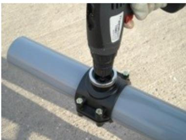
Bohren Sie nun ein Loch in das Rohr. Achten Sie darauf, nicht die Gegenseite des Rohres oder das Gewinde der Anbohrschelle zu verletzen.
