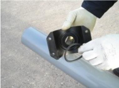
Setzen Sie den O-Ring ein und positionieren Sie die obere Hälfte der Anbohrschelle auf dem Rohr.
