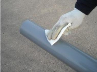
Reinigen Sie die Oberfläche des Rohres.
