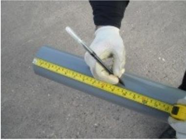
Markieren Sie die Position auf dem Rohr.
