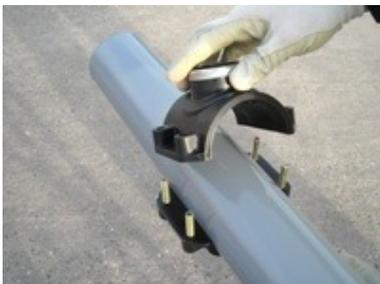
Verbinden Sie die untere Hälfte mit der oberen Hälfte der Anbohrschelle. Führen Sie die Schrauben von unten ein und ziehen Sie die Muttern von oben fest.
