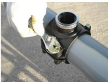
Bei vier oder mehr Schrauben ziehen Sie die Schrauben diagonal gegenüber fest.
