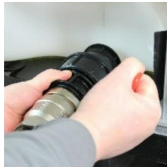
**4** Nachdem der Anschluss fest verbunden ist, drehen Sie am Hebel des Kugelhahn im Uhrzeigersinn den Kugelhahn in die Endstellung. Hierzu kann auch die Überwurfmutter des Klemmfittings leicht geöffnet werden - dies ist aber nicht Zwingend notwendig.
